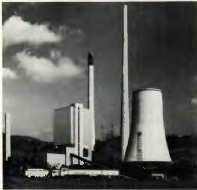
Schornstein, Naturzugkühler und Kohlekraftwerk Elverlingsen
