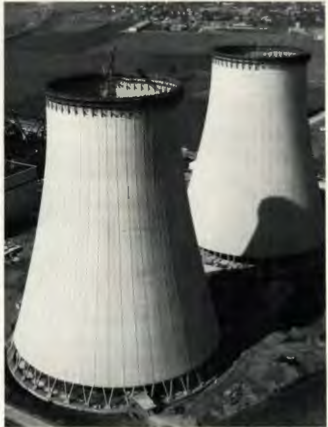
Naturzugkühler für das Kernkraftwerk Grohnde (Freigabe Nr. 13655/81)
