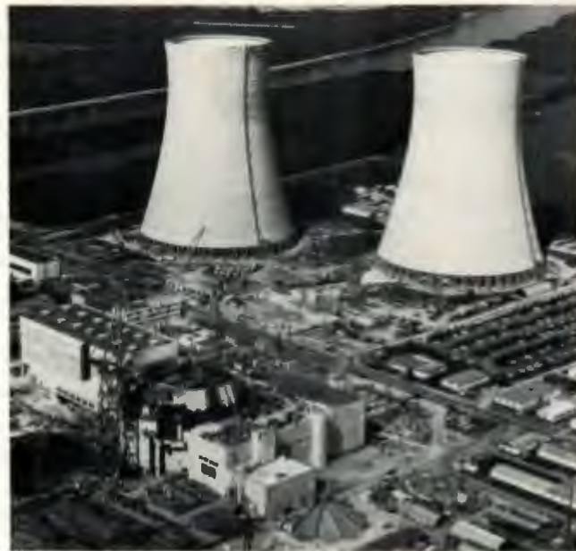
Kernkraftwerk* und Naturzugkühler Philippsburg (Freigabe Nr. 13654/81)
